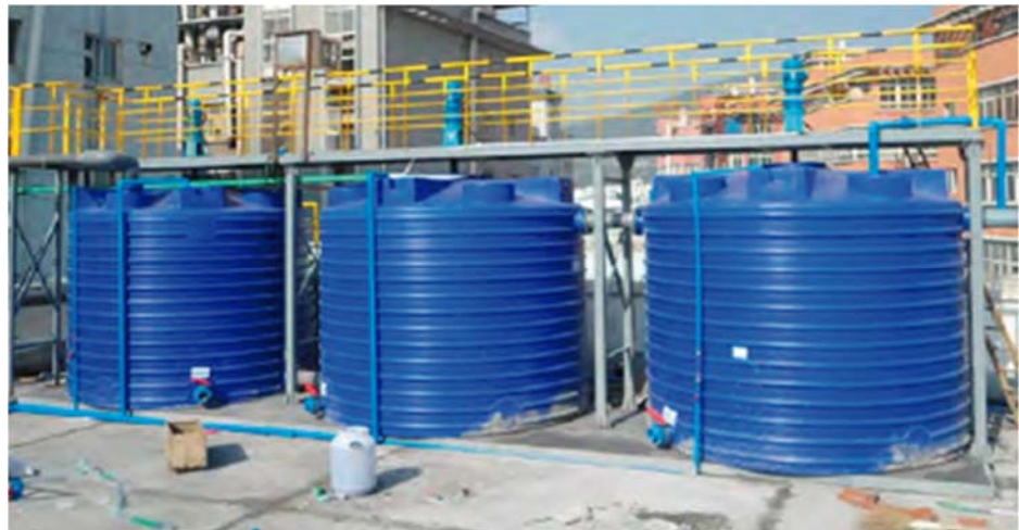
Tanque de ajuste de pH n° 1
